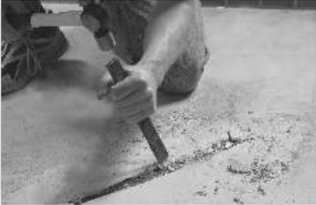
La sonde doit aller du thermostat vers le milieu du plancher, pour un minimum de 10". Si un tube est utilisé, il doit être partiellement recouvert. Faites un canal pour le tube d'environ 5/16 "profondeur x 5/16" de large dans le sol à partir du mur.
